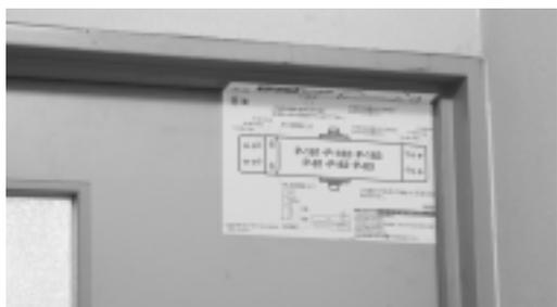
ドアの開き方向を確認し、取付型紙を使います。
