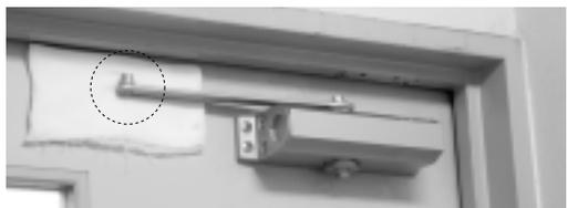
閉扉速度調整バルブが戸先側(ドアノブ側)に向くように取付けて下さい。
