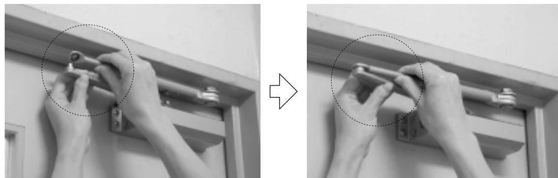
メインアームを引き寄せながら、調整ネジ棒がドアと平行になるように回して長さを調整し、しっかりとはめこんで結合して下さい。
